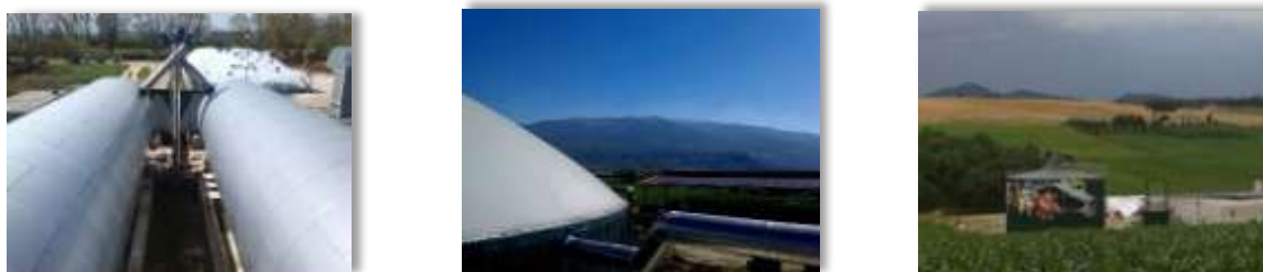
Figura 7 – progetto BYPRO-ENERGY – Impianto di Biogas alla Coop. Agricola Trevi
